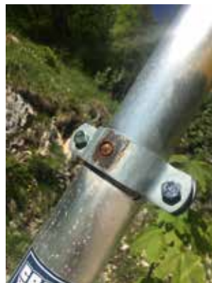
Abb. 3: Unbeabsichtigte Sollbruchstelle der Schilderbefestigung.
