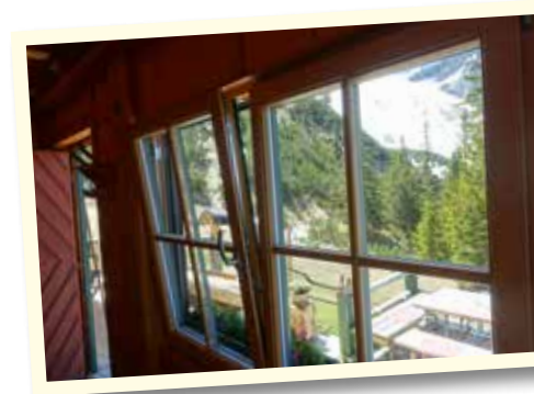
Neue Fenster von innen
